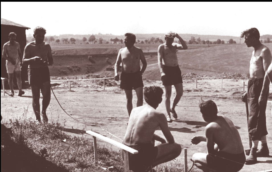
vyměřování základů hvězdárny (jaro 1964)
